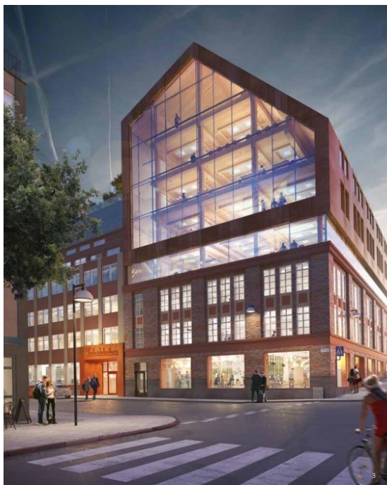
Referensexemplet Trikafabriken, Södra Hammarbyhamnen Stockholm, ombyggnation 2016-19
