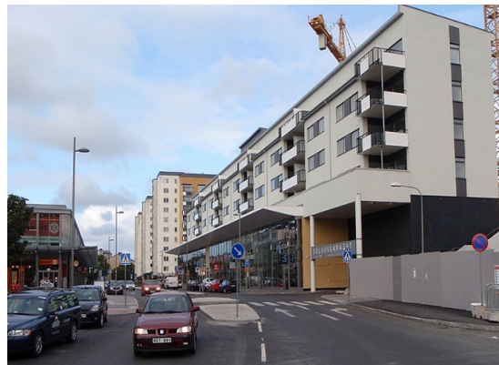
Påbyggnad med volymelement ovanpå befintligt parkeringshus 2006–08 genomfördes i samband med moderniseringen av den klassiska abc-staden Vällingby, Stockholm
